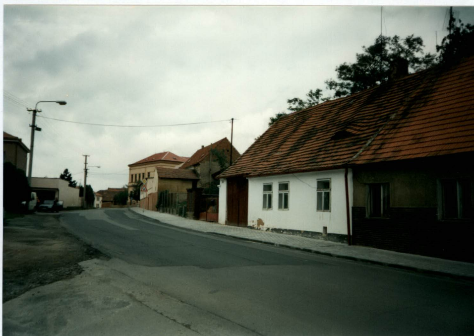
Dokončen chodník od školy v ul. V Radčicích
