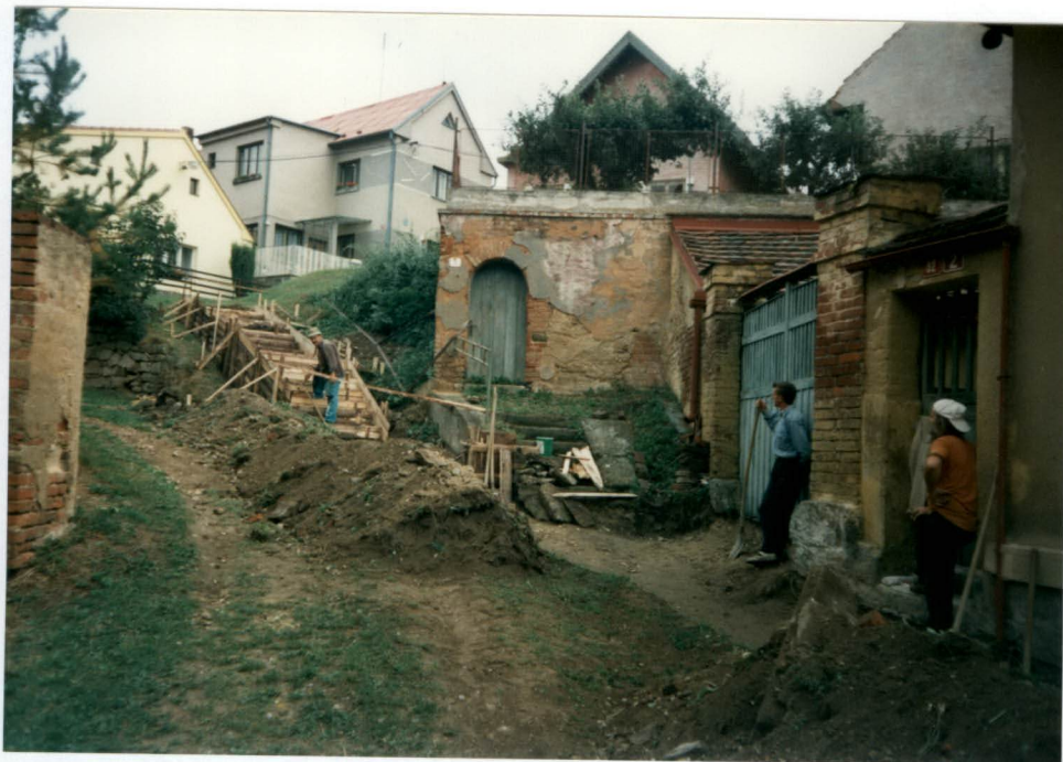
Nové schody a chodník v ul. Na Zábradlí provedla fa. KNT - Tišer, Brněnská 24, Plzeň
