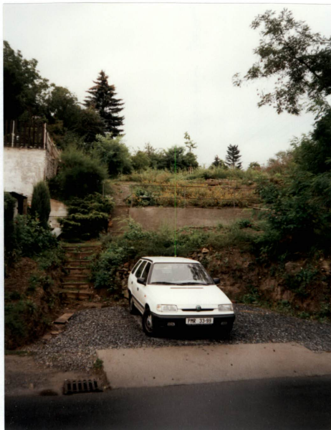
Dokončená úprava „Kovářovic rokle“
