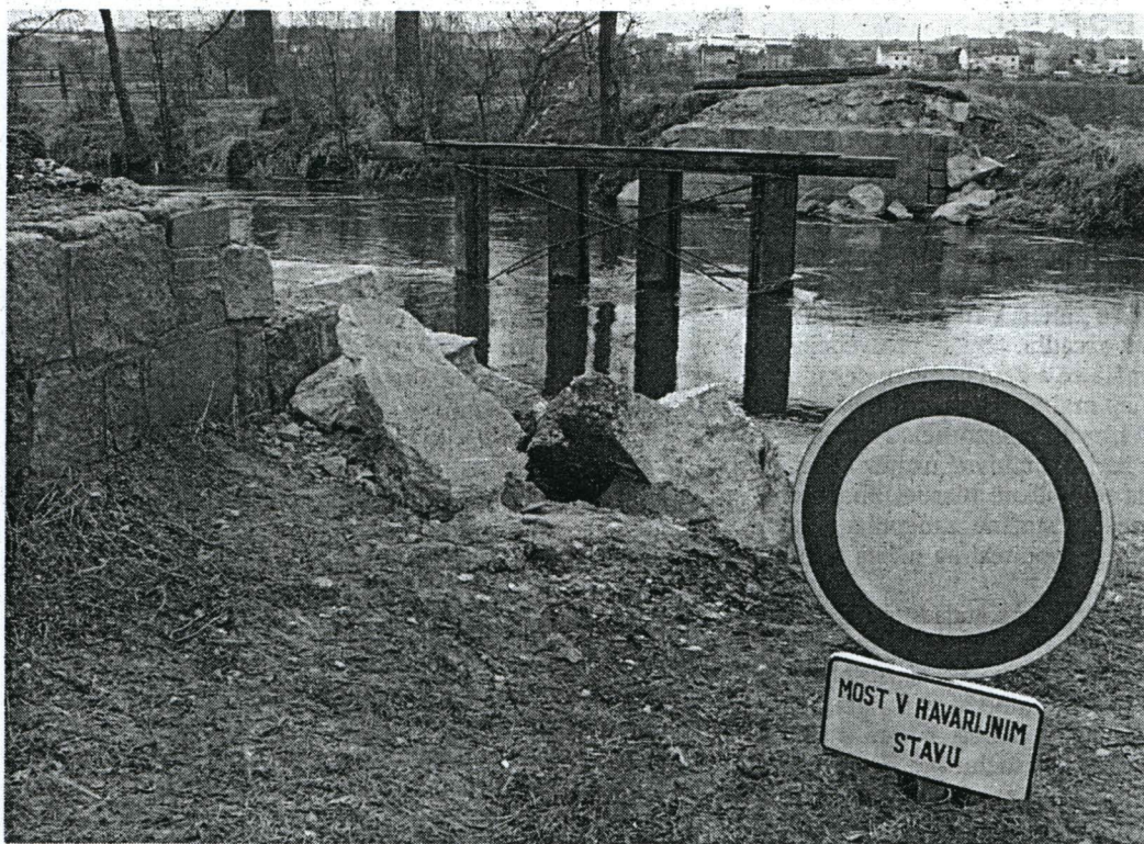
Most přes řeku Mži v Radčicích se v těchto dnech nachází ve stadiu rekonstrukce. Opravy ale zdržuje vysoký stav vody, a tak dubnový termín dokončení opravy bude zřejmě o trochu prodloužen. Foto JAROSLAV VOGELTANZ
