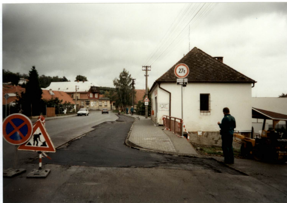
Oprava chodníku před samoobsluhou
