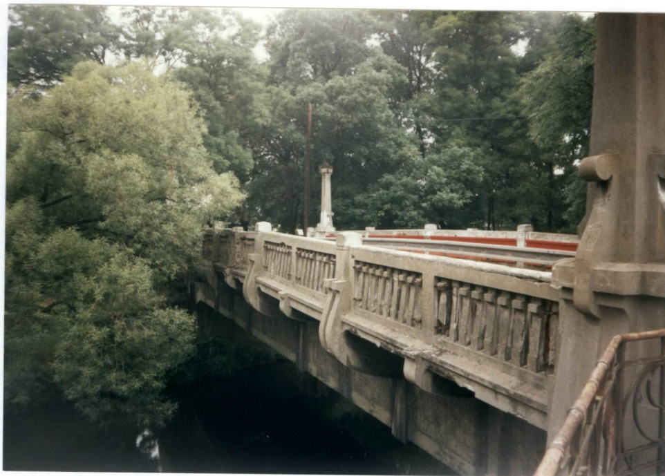
Po opravě – prosinec 2002
