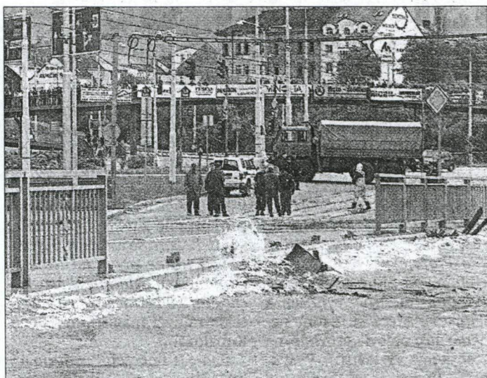
11.30 - Hasiči odřezali zábradlí na starém mostě u Jána, aby nezačtyávalo zaplaveniny. Foto Jaroslav Vogeltanz
