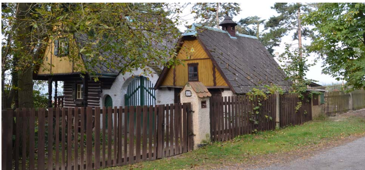
východní část usedlosti
