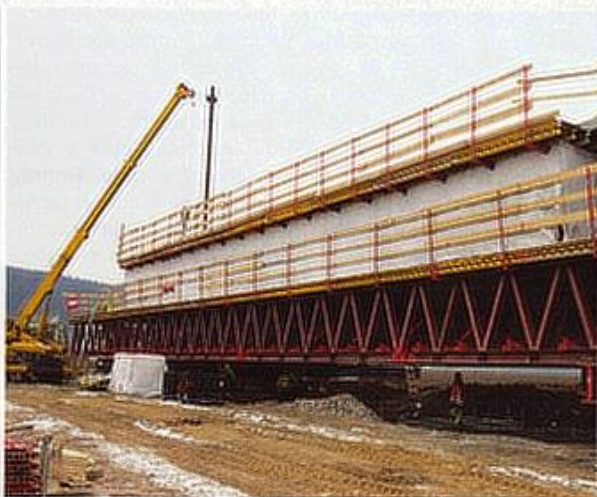
Pro stavbu mostních pilířů se využívá betonová skruž
