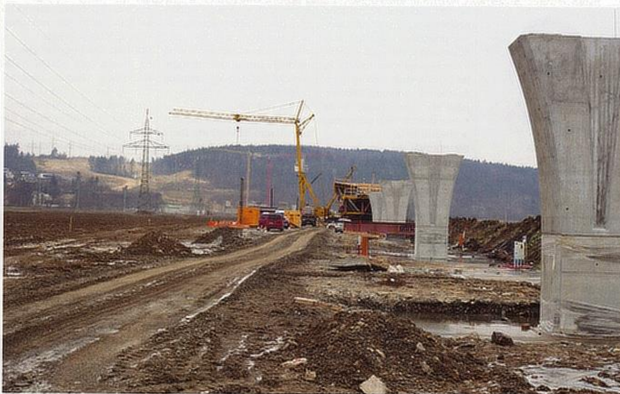
Celkový pohled na stavbu částí estakády
